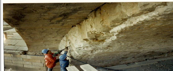
Etat des voûtes
