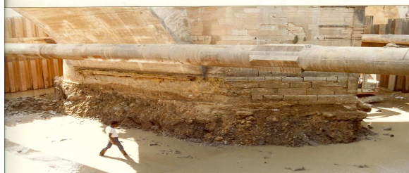
Etat des fondations sans pieux
