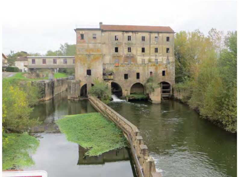
Ecluse et barrage d'Aiguillon
